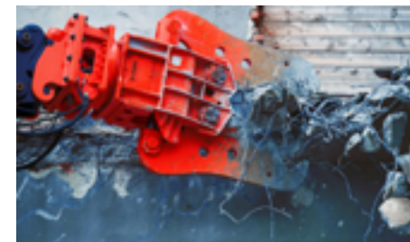
Strip Out e Demolizioni
